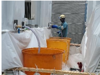
油入機器の抜油作業
