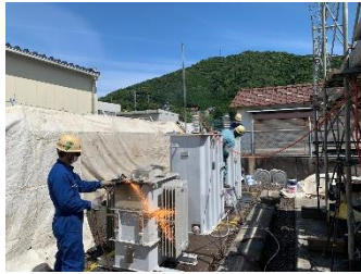
隣地への飛散防止対策
