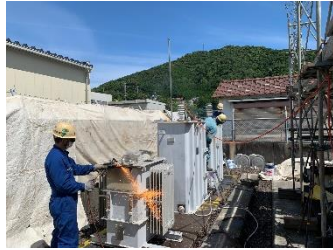
隣地への飛散防止対策
