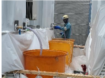
油入機器の抜油作業
