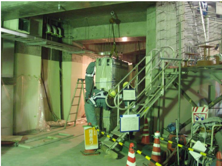
発電機の運転や管理に関する 制御盤や機械の据付
