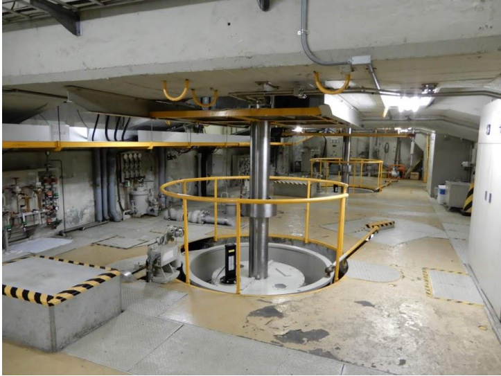
水力発電所内部の様子
